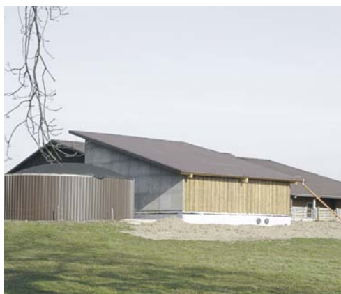
Biogasanlage Loorenhof, Schweiz
