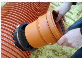
Das Rohr in die Insitu Dichtung einführen.
