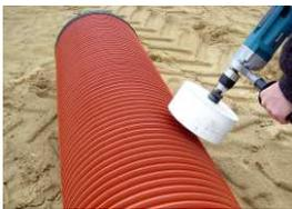
Die Bohrung in der angegebenen Größe herstellen und das Bohrloch entgraten.
