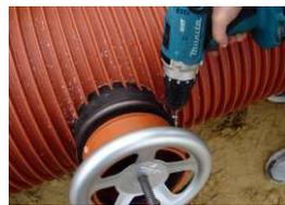
Vor Entfernen des Werkzeuges das Spannband mit 8Nm anziehen.
